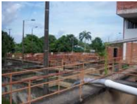
Fotografía 2. Planta de tratamiento PTAP
