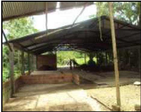
Foto 5. Zona de Compostaje
