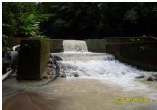
Foto N° 1: Obra de captación sobre el caño Palomas
