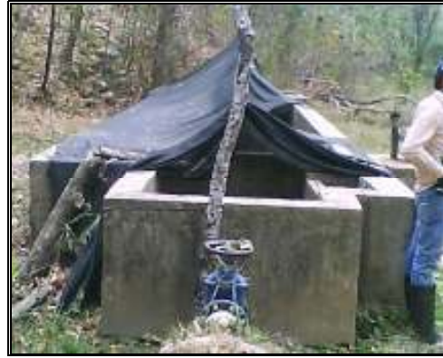
Fotografías 2 y 3. Desarenador en funcionamiento y desarenador nuevo (fuera de servicio).
