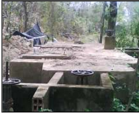
Fotografías 2 y 3. Desarenador en funcionamiento y desarenador nuevo (fuera de servicio).
