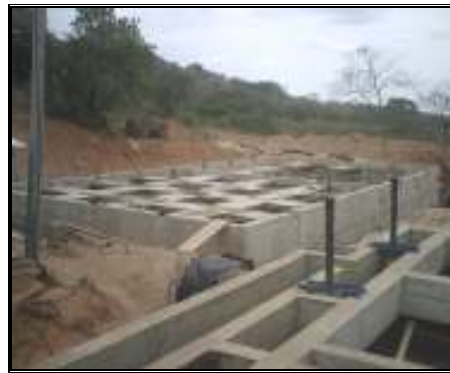
Fotografías 4 y 5. Tanque de almacenamiento en uso y tanque en construcción
